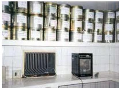
**Figura 4.14:** Desumidificador e ar condicionado da câmara seca da Flona de Nísia Floresta – RN.
